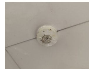
防火設備連動用感知器
